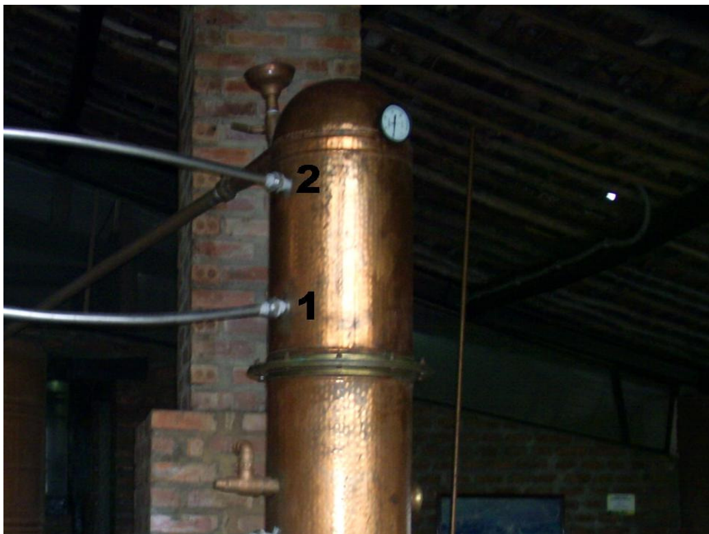
Figura 5B. Dispositivo de refluxo da coluna do estabelecimento “C”: (1) Entrada de água; (2) Saída de água.
