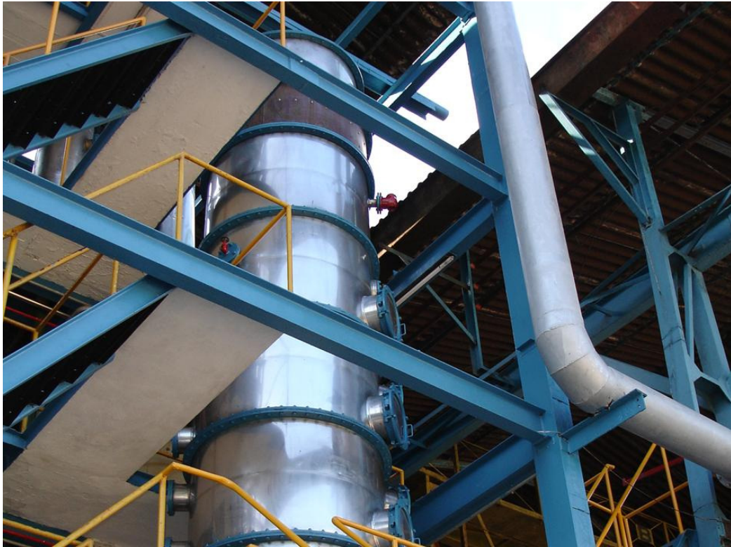
Figura 13B. Visão da coluna "1" do fornecedor "F1", mostrando detalhe de uma secção externa de cobre.
